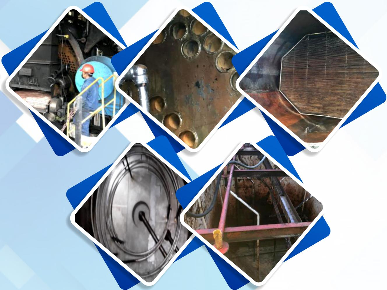
Somos una empresa dedicada a la recuperación de sus activos: limpieza, desincrustación y restauración para asegurar su operación y eficiencia en los procesos de producción. Se cuenta con equipos de lavado de presiones desde los 3500 Psi hasta los 20.000 psi, personal calificado, disposición y todos los requerimientos de HSEQ.
